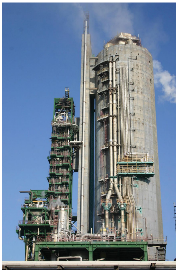
Wieża granulacji mocznika w Policach
